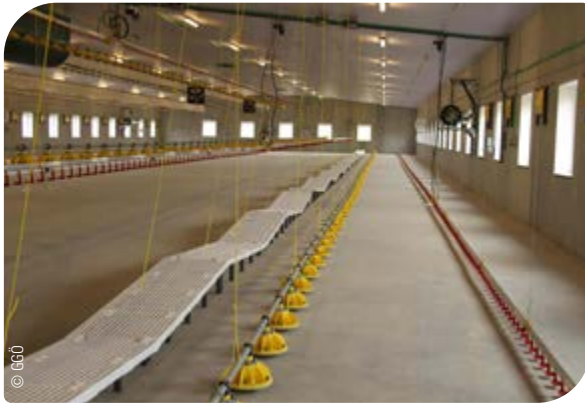
Abb. 97: Futter- und Wasserlinien werden im Stall abwechselnd montiert, wobei an der Wand mit einer Wasserlinie begonnen wird.
