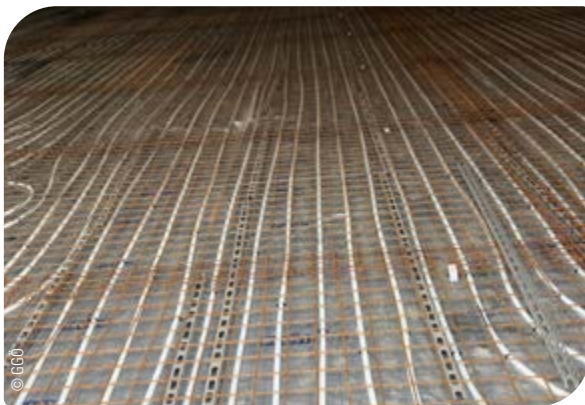
Abb. 98: Fußbodenheizung
