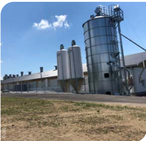
Abb. 96: Hühnerstall mit Silos
