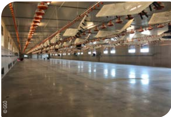
Abb. 90: Hühnerstall mit Betonboden
